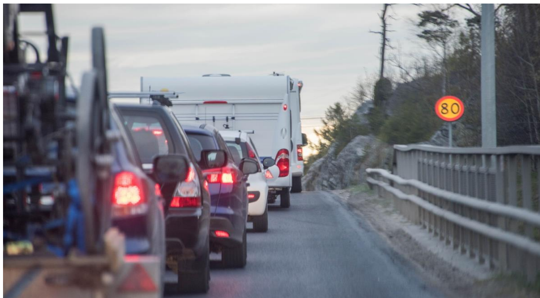
Många trafikolyckor vid vägarbeten inträffar i köerna som bildats i samband med vägarbetet. Foto: Sten-Åke Stenberg.
