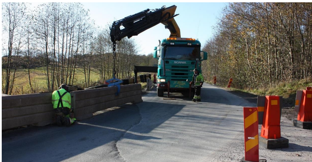
Montering av längsgående skydd, i rapporten kallat för "betong". Foto: Eva Liljegren.
