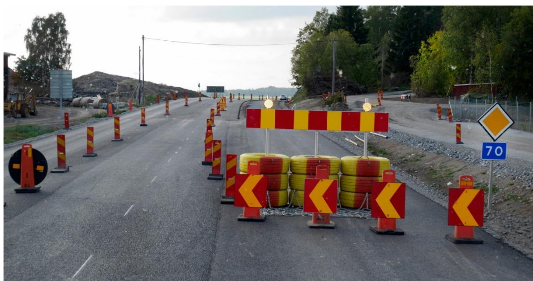
Däcksbuffert som används vid vägarbete för att förhindra att trafikanter kör in i arbetsområdet. Foto: Göran Fält.
