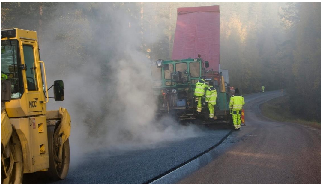
Personal på vägen under beläggningsarbete. Foto: Ulf Palm
